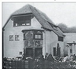
Haus Christiansen, 1944 zerstört
