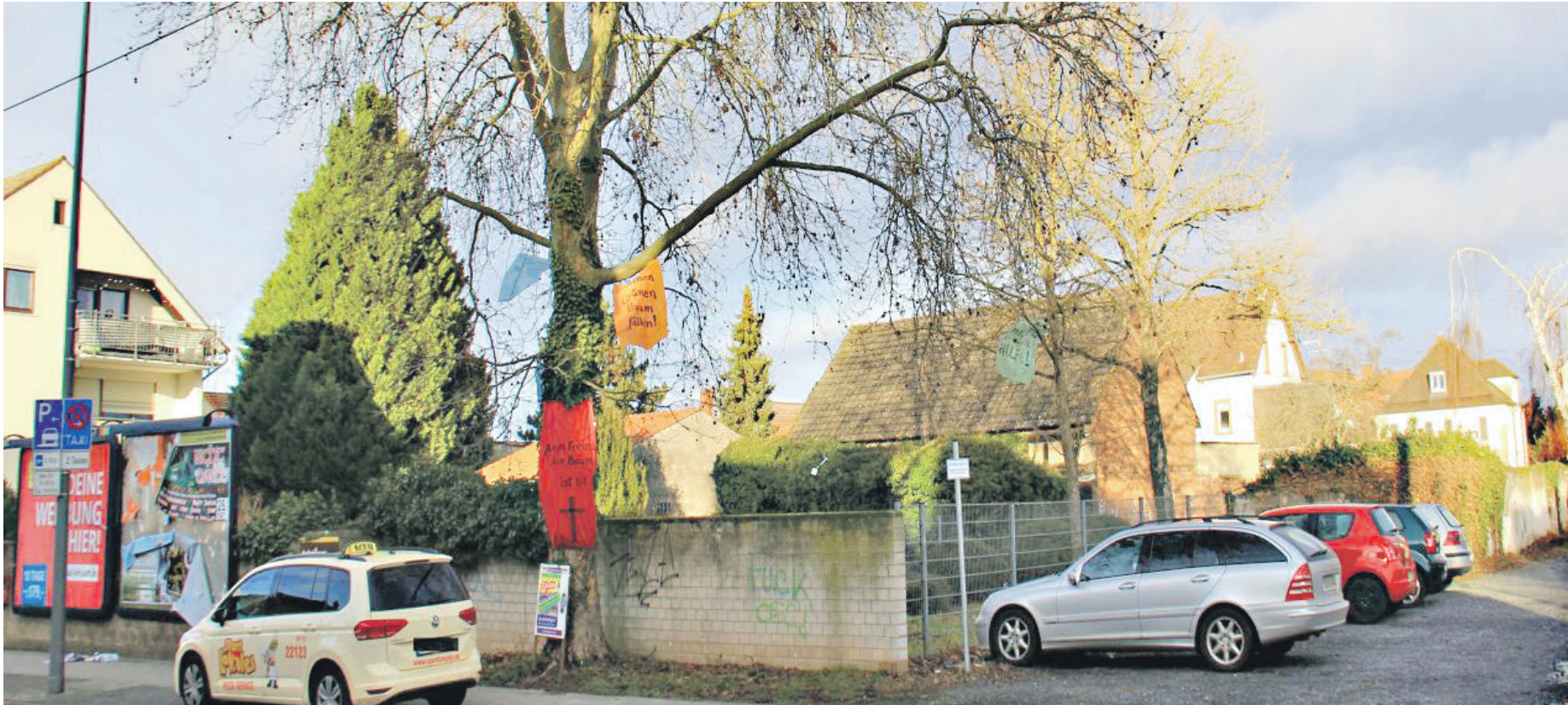
Arheiliger Ortskern: letztes freies Grundstück soll für Aldi zubetoniert werden: 90% Überbauung, kein Grün, keine öffentlichen Wege, weniger Wohnungen als mit geltendem Bebauungsplan möglich.
