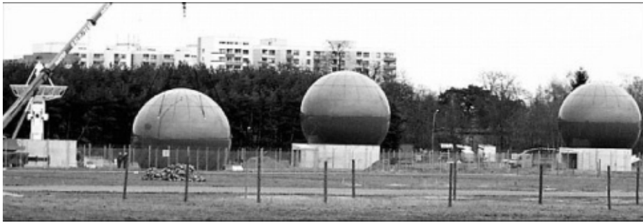
Baustelle der US-Abhöranlage
